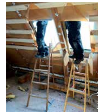
Renoveringen af præsteboligen er i fuld gang.
